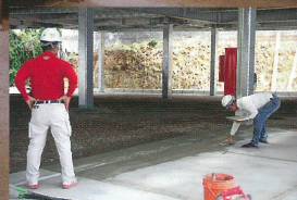
立体駐車場の左官工事
