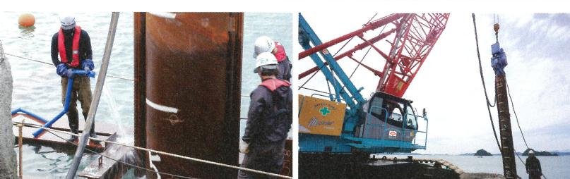
バイブロハンマーを稼働させ、海中の打ち込み作業が開始。地盤の硬さや状態にもよるが、一本あたり概ね一時間をする。打ち込み時には震動で鉄板同士が擦れ合い、熱を持ってしまうため、サポート役の職人が動作部分に海水をかけて冷却作業を行う
