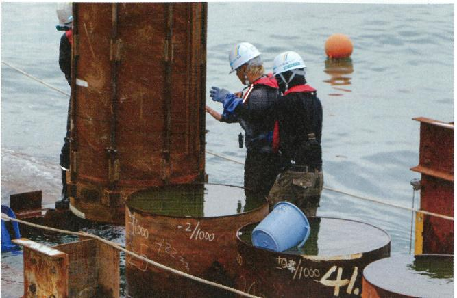
クレーンで杭打ちポイントまで運んだ後、矢板のオース型、メス型の溝を合わせ、最終的な位置決めを行う。その後、ウォータージェットを噴射させながら、自重で海中へと埋め込ませて行く
